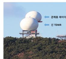
< 공항기상레이더 철거 후 >
